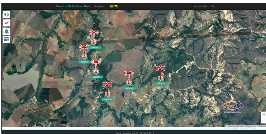
Figura 4-12 - Sistema supervisorio das 6 sirenes de Patos de Minas Fonte: WA066210001-1-RH-RTE-0147– Revisão 2
